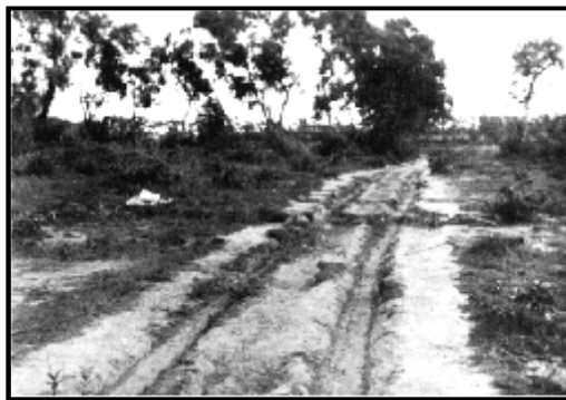
台中州新庄子西方道路之屯仔腳地震斷層露頭，道路被斷層切割成十多段，水平與垂直總錯位量約30公分，斷層二側的民宅全倒
