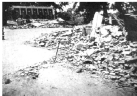
內埔公學校的屯仔腳地震斷層露頭，水平錯動15公分，垂直落差10公分。
